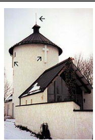
Wahrhaft „ausstrahlende“ Wirkung: Das Kreuz am Friedhof ist die Verkleidung einer Mobilfunk-Antenne.
